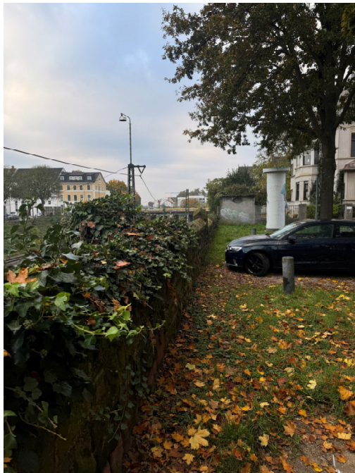
Abbildung 4: Mauerwerk als Böschungsabschluss auf der Höhe der Gutenbergstraße (links) mit einer mittleren Höhe von 1,0 m (rechts)
